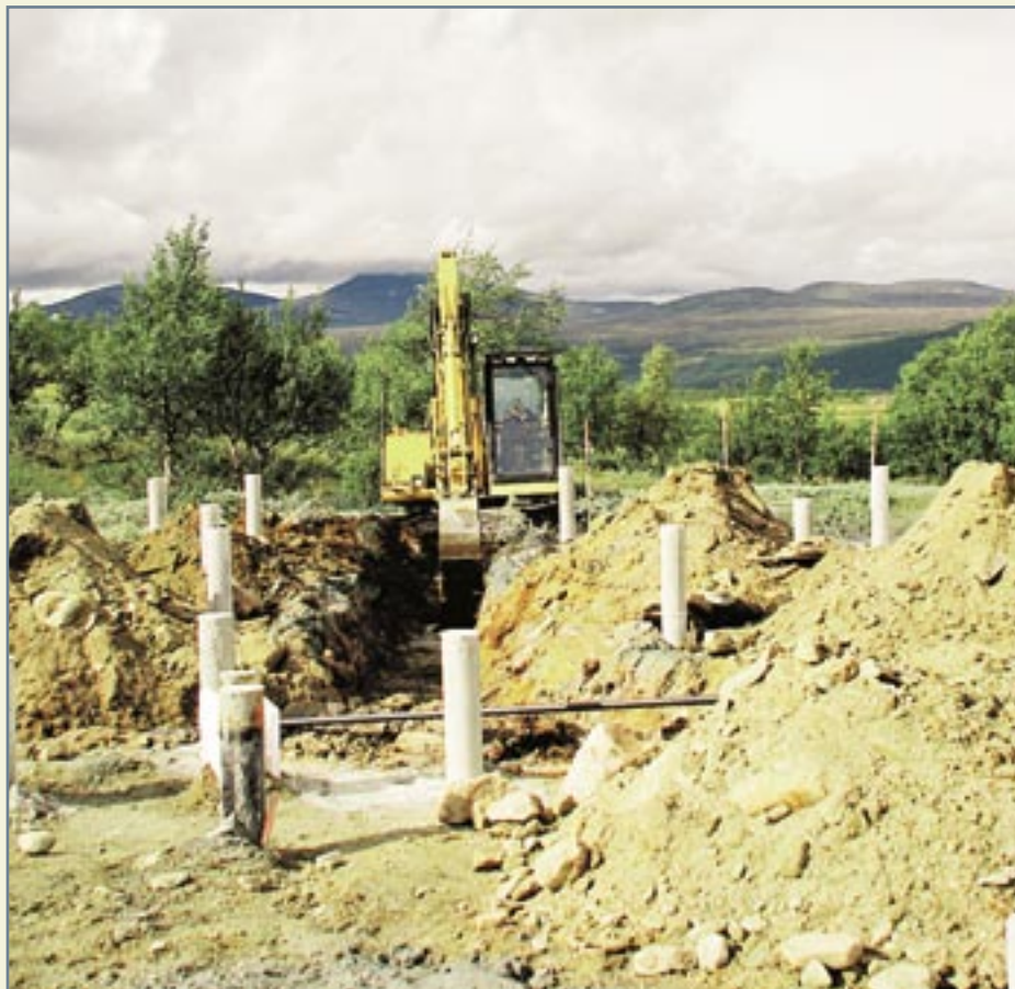
Femtionio borrhade plintar fick Jämtborr borra ner till fast berg för att skapa en riktig stabil grund för restaurangbyggnaden. Foto: Jan Eriksson
