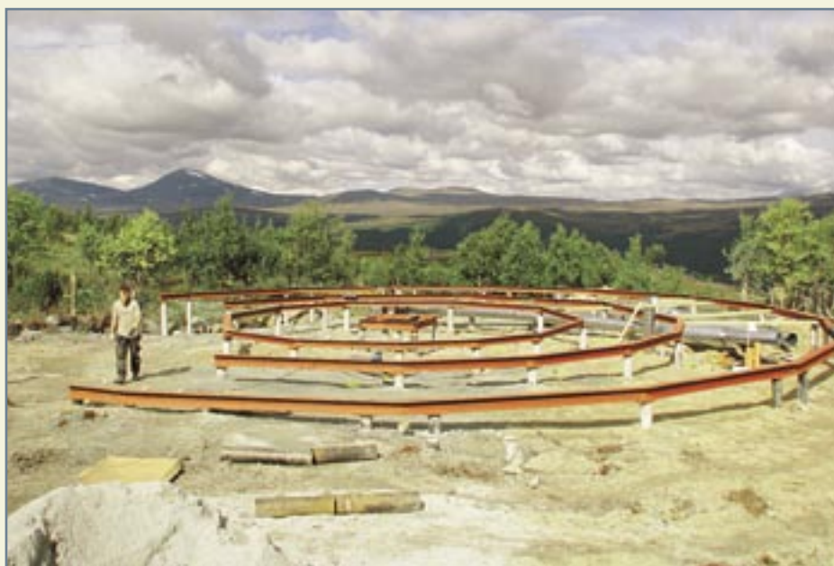
Huskroppen vilar på stål balkar som förankrats i de borrhade plintarna. Borrhingstekniken är överlägsen när man behöver skapa mycket stabila grundkonstruktioner. Foto: Jan Eriksson
