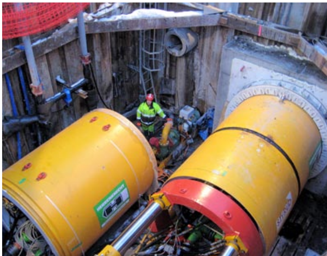
Här pågår borrning med mikrotunnelteknik! Till höger syns ett betongrörelement som trycks in i borrhålet, medan rörelementet till vänster i bild väntar på sin tur. Foto: Styrud AB.
