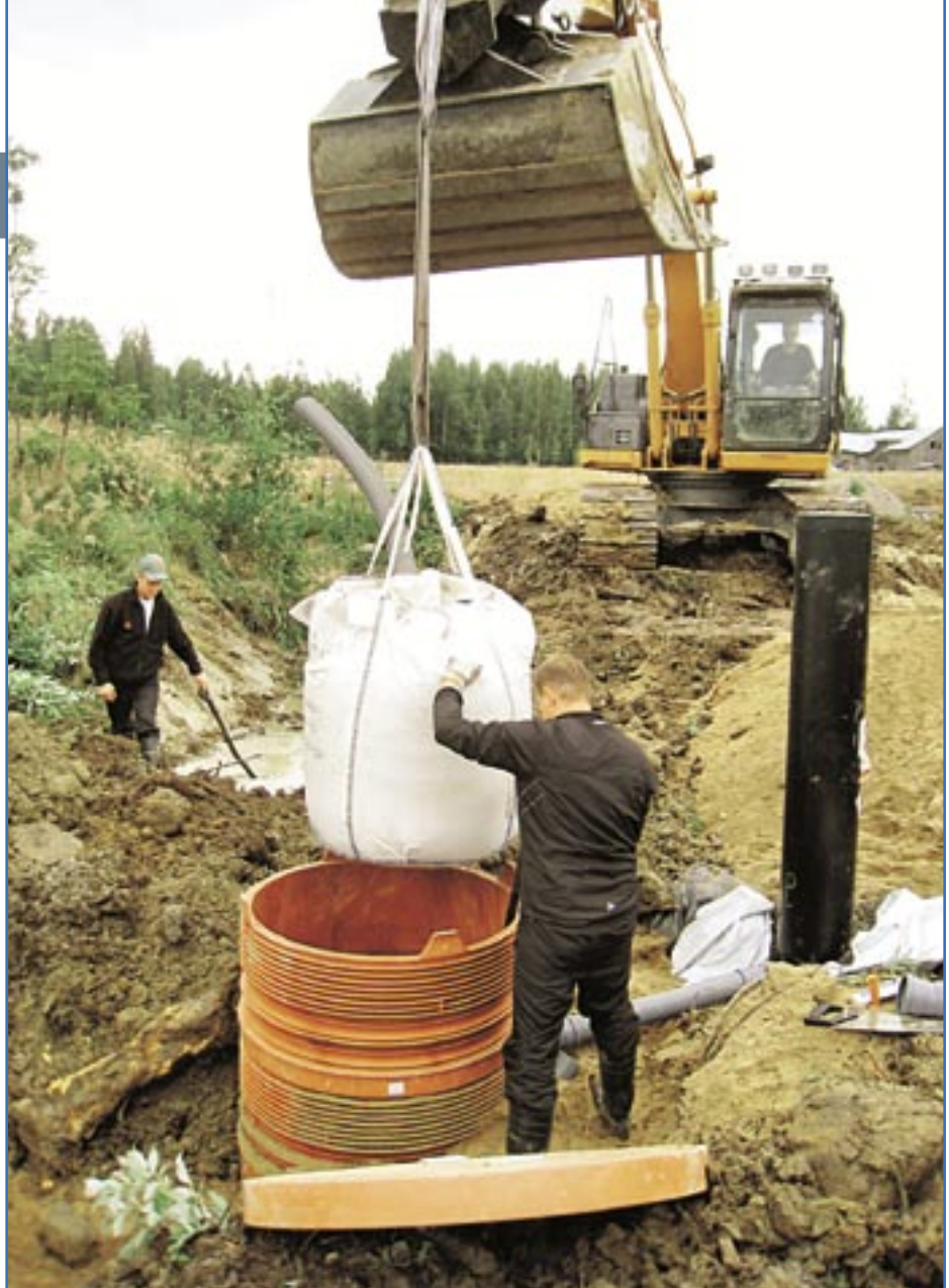
Ett filter med fosforbindande material kan installeras som komplement till en markbäddslösning. En sådan anläggning är både lättskött och funktionssäker. Foto: Axel Alm, Nordkalk.
